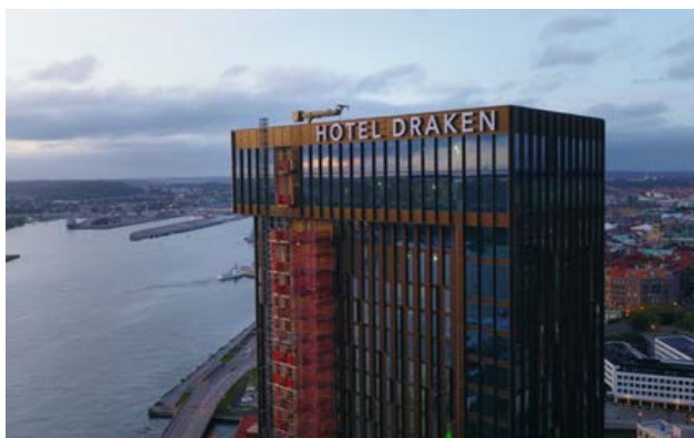
Nya Hotell Draken blir Göteborgs högsta hotell. På uppdrag av entreprenören K21 är PE huvudkonstruktör i projektet. Genom bygghandlingen fick vi även förtroende av UPB att konstruera byggnadens stomme.
